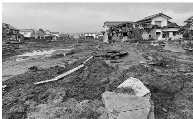
長野市穂保の堤防決壊現場近くの風景。
