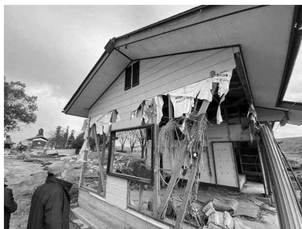
濁流で破壊された消防団詰所（長野市穂保）。
